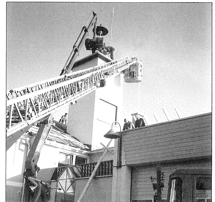
Einsatz aller technischen Geräte
