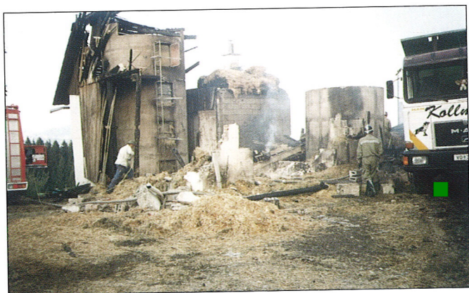
Wirtschaftsgebäudebrand bei Unterhuber
