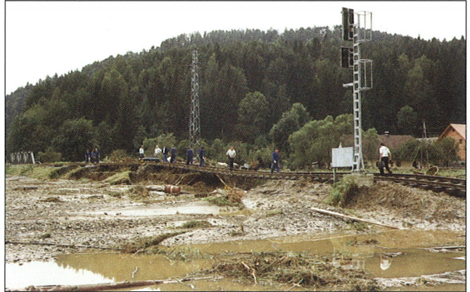
Eine unterschwemmte Bahnlinie in Krottendorf
