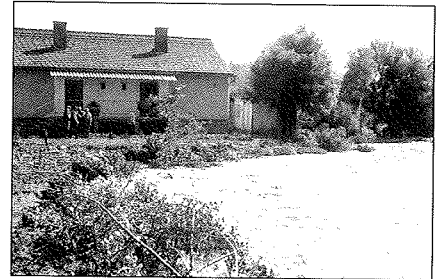
Durch das Einhängen von Bäumen konnte das Wohnhaus gerettet werden
