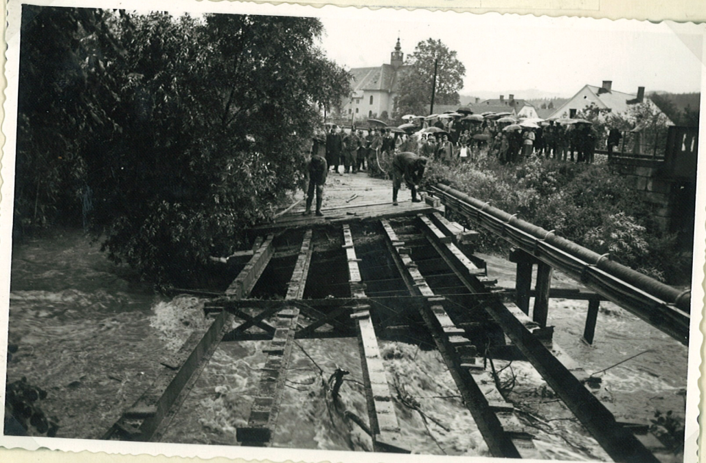
Hochwasserkatastrophe am 1.8.1965 in Voitsberg Die Kaspar-Brücke wird von der Stadtfeuerwehr abgetragen.
