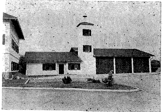
Das neue Rüsthaus der Freiwilligen Feuerwehr Stallhofen.
